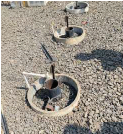
Fig. 2 : Separate earth pits
